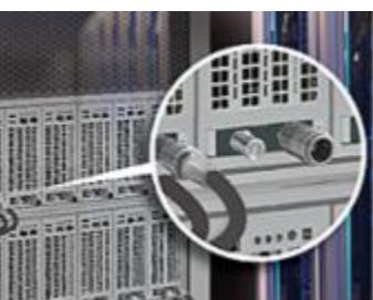
小型ながら大流量で冷却効率を高めるカプラです。独自の構造により分離時の液だれ量を低減します。ワンタッチ接続のため、作業効率にも貢献します。
